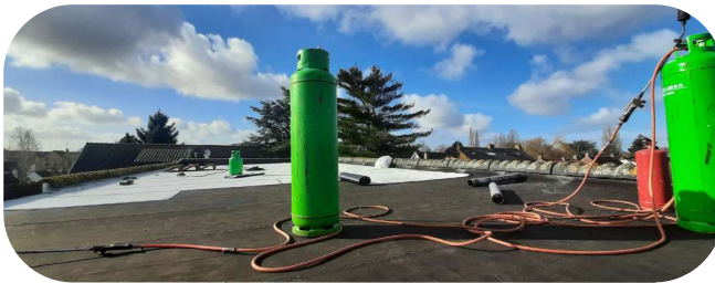
Plat dak vernieuwing
